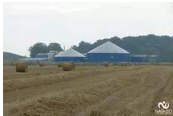
Unité de méthanisation située en Normandie. Naskeo Environnement, Author provided
